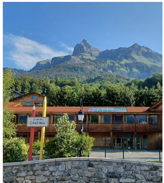
École de Passy-chef lieu construite principalement en bois
